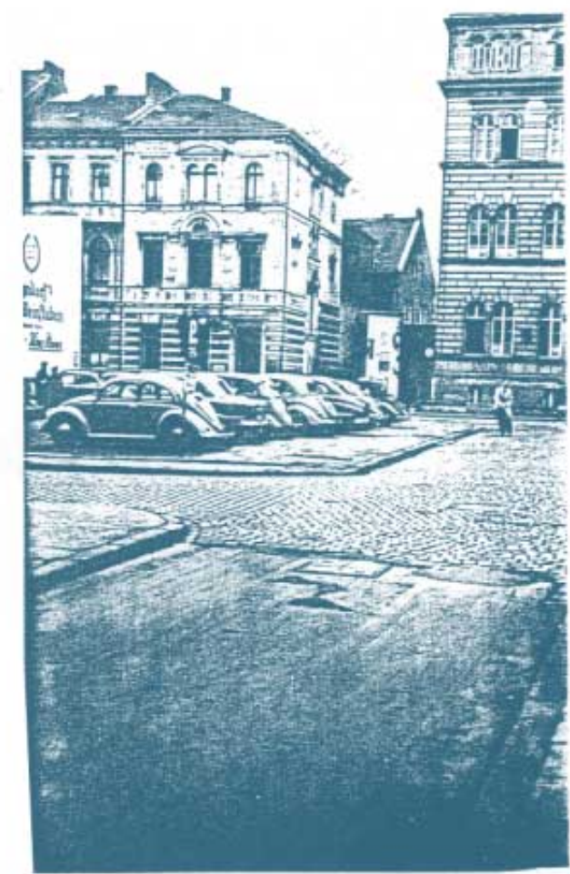
Im Hintergrund rechts der Südflügel des Landgerichts, links daneben das Haus Wilhelmstr. Nr. 17, das im Zuge des Straßendurchbruchs südlich vom Landgericht im Sommer 1957 abgebrochen wurde.
